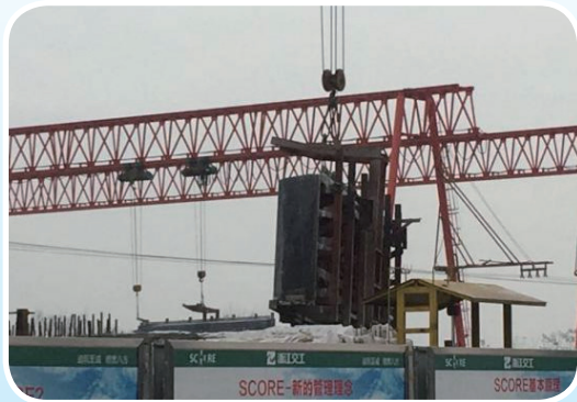
改进后：在吊具的端头增加配重，保持模板平衡，保证了吊装过程的稳定性
